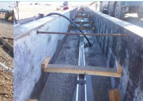
Tal como se ha indicado anteriormente, se recomienda realizar dos vertidos de hormigón debido a la gran fuerza que se ejerce sobre las paredes del canal. El cuerpo estructuralmente monolítico de los canales Slotdrain garantiza que no se doblen ni se estrangulen los cuellos. Una vez vertido hasta arriba y antes de que empiece a secarse, se han de aplicar los aditivos correspondientes al acabado superficial.
