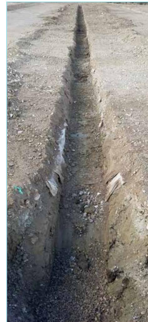
La base sólida de hormigón deber ser lo suficientemente ancha para permitir la instalación del refuerzo de acero alrededor del canal y el encofrado para el dado de hormigón si fuese necesario. Una vez colocado, alineado y fijado, con alambres como muestra la foto o con hormigón u otros medios, es el momento de colocar la cinta protectora.
