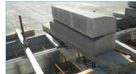
Verter el hormigón con un mínimo de resistencia HA35 hasta 20 mm por debajo de la arista inferior del canal. El hormigón debe cubrir completamente tanto los pies del canal como las barras estabilizadoras si las tuviera.
