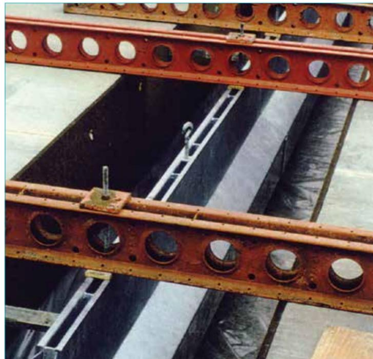
A continuación, deben formarse las juntas de dilatación longitudinalmente. Pueden mantenerse en su sitio mediante maderas.
